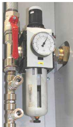
Fig. 83 : Alimentation en air comprimé
