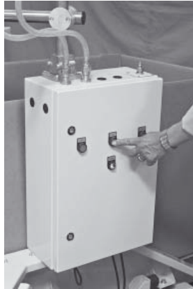
Abb. 4.3 Start-Drucktaster für Kipplage
