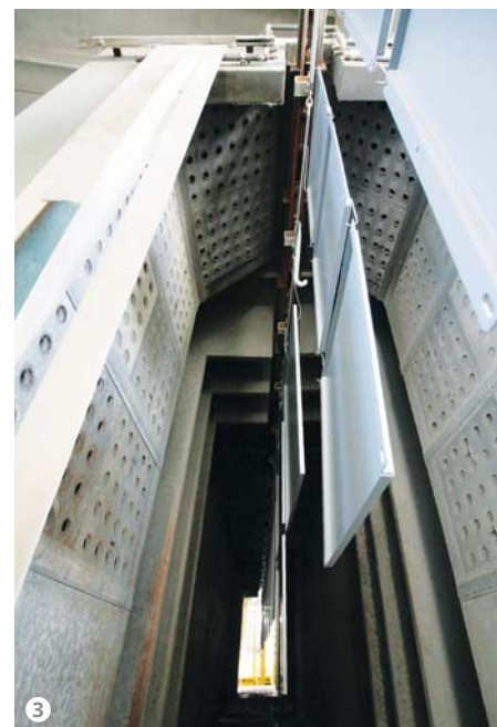
Figura 3: Ingresso dei pezzi nel tunnel di pretrattamento a 5 stadi.
